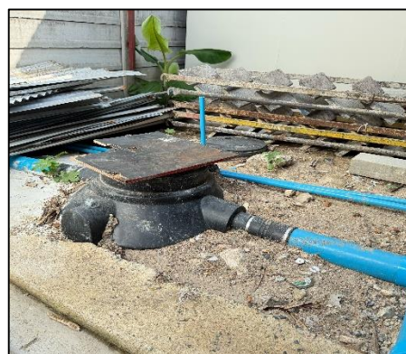
ภาพที่ 29 ถังบำบัดน้ำเสียสำเร็จรูป ชนิดเติมอากาศ
