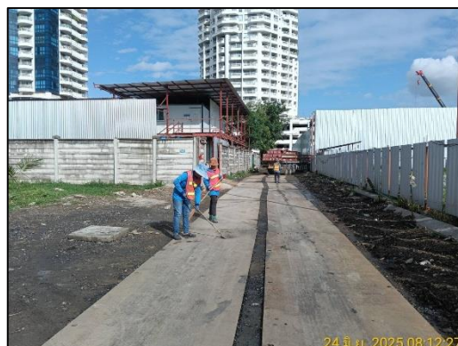
ภาพที่ 17 แผ่นเหล็กปูบริเวณภายในพื้นที่โครงการ
